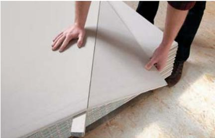
Die Gipskartonplatte wird dazu mit dem Messer an der Oberseite entlang der Schneidhilfe angeritzt und danach über einer Kante vorsichtig gebrochen. Nun kann – falls notwendig – der rückseitige Karton durchgeschnitten werden.
