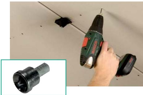
Um die Schrauben fachgerecht zu versenken und die Platte beim Verschrauben nicht zu beschädigen, wird ein spezieller Innenausbau-Bit mit angespresstem Tiefenanschlag eingesetzt. Als gängigster Schraubenantrieb wird hier ein Phillipsbit mit Größe 2 verwendet. Die Schraubenfolge ist wichtig um Stauchungen der Platten zu vermeiden, kann aber je nach Hersteller unterschiedlich angegeben sein.
