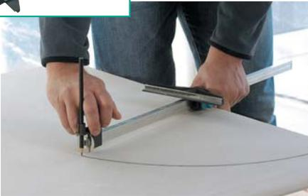
Werden mehrere gleichgroße Streifen von den Platten benötigt, so ist dies das ideale Einsatzgebiet des Streifen- und Kreisschneiders: Das gewünschte Maß wird eingestellt und die Streifen mittels Schneidrad vorgeritzt und danach wie gewohnt über eine Kante gebrochen.
