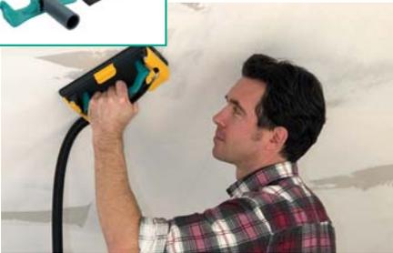
Besonders die Fugen der Gipskartonplatten werden Platte für Platte geschliffen, so dass auch tatsächlich alle überschüssigen Reste der Spachtelmasse entfernt werden. Mit einem ergonomischen Handschleifer und einem Streifen Gitterleinen kann dies unproblematisch nur mit einer Hand erfolgen. Für mehr Kraftübertragung bei groben Überständen, lässt sich der Schleifer auch beidhändig bedienen.
