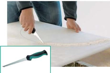
Größere Löcher oder Ausschnitte werden angezeichnet und können dann mit der Handstichsäge ausgeschnitten werden. Ein Vorbohren ist durch die angeschrägte und angeschliffene Spitze am Sägeblatt nicht notwendig.
